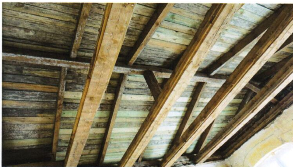
Więźba dachowa zaatakowana licznymi grzybami pleśniowymi,.
