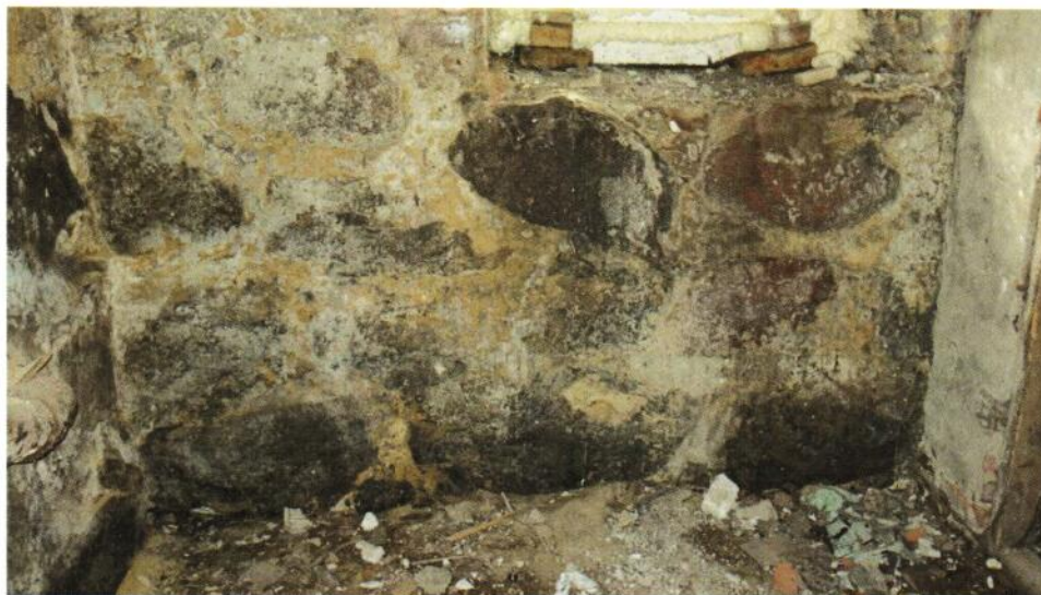
Stan tynków na przegrodach piwnic obiektu – uległy one w przeważającej mierze destrukcji i wymagają prac naprawczych
