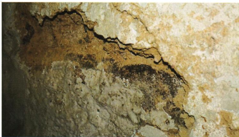
Odspojony tynk odsłania istniejący materiał budulcowy
