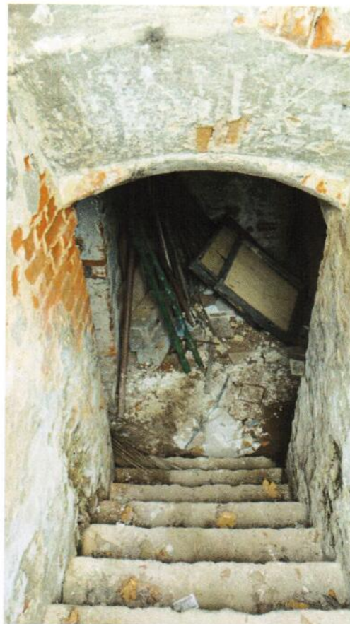
Wejście do piwnic – od strony zewnętrznej budynku, od strony południowej. Destrukcja schodów oraz tynków i ścian.
