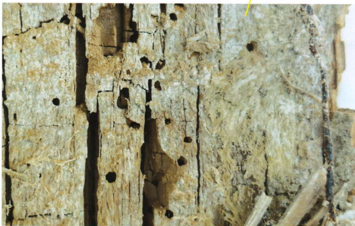
Fragment fotografii, ukazanej powyżej. Po lewej stronie fotografii: poprzeczne spękania włókien celulozowych drewna oraz otwory wylotowe owadów – technicznych szkodników drewna, po prawej: grzybnia grzyba domowego właściwego.
