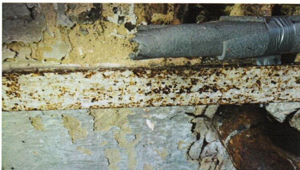
Stropy odcinkowe w piwnicach. Widoczna daleko posunięta korozja istniejących belek. Świadczy to o długotrwałym oddziaływaniu wilgoci.
