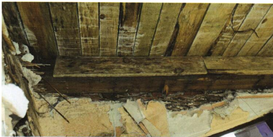
Naprawy i uzupełnienia ustroju więźby dachowej. Widoczne również ślady po przeciekach na deskowaniu.
