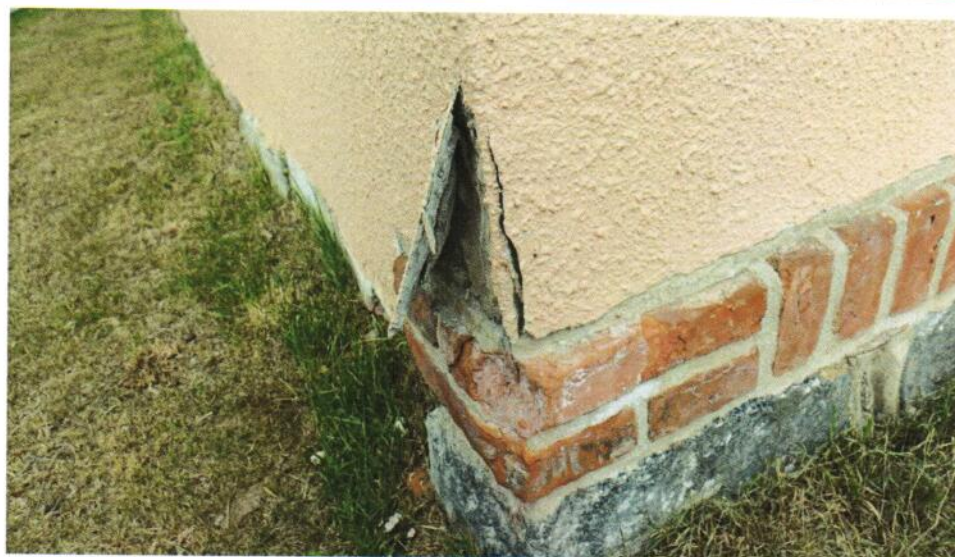
Tynk na odnowionej elewacji odspaja się
