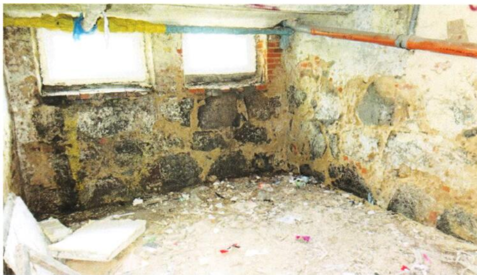
Ściany piwnic – w całości lub na przeważającej większości powierzchni są pozbawione tynków.
