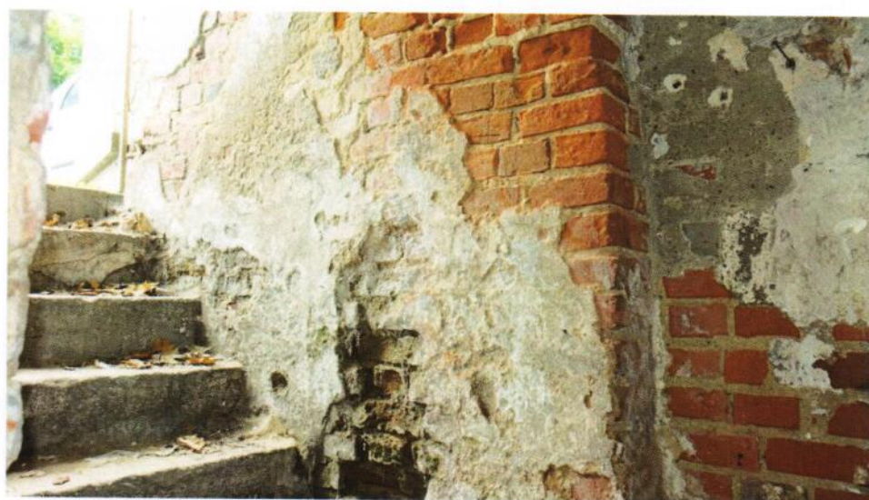
Odspojone tynki na jednej ze ścian przy zejściu do piwnic obiektu
