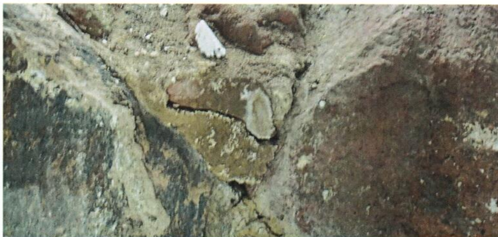
Stan tynków na przegrodach piwnic obiektu – uległy one w przeważającej mierze destrukcji i wymagają prac naprawczych
