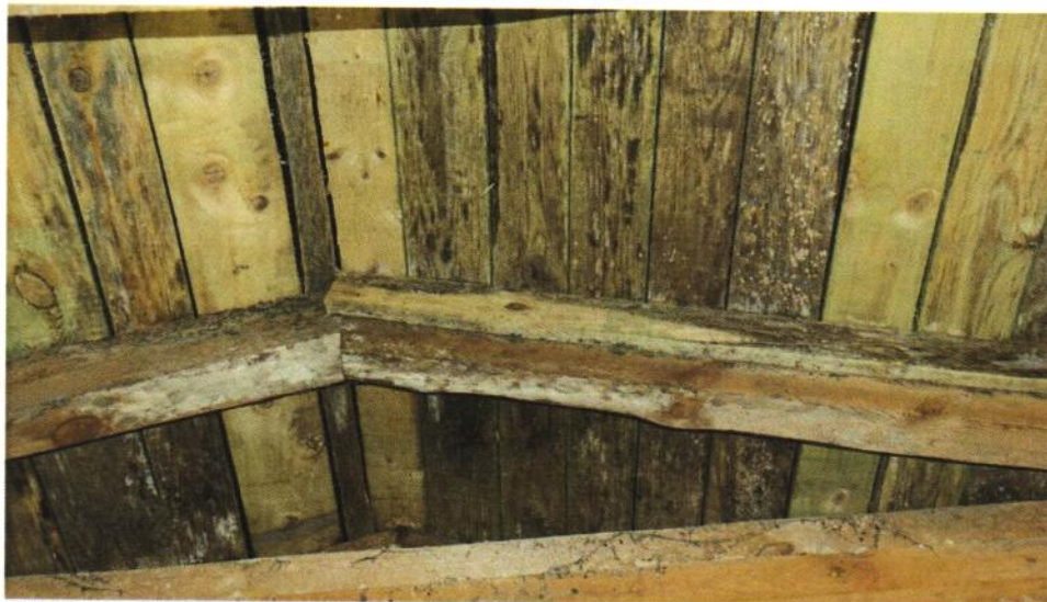
Kolejny fragment więźby, pokrytej grzybami pleśniowymi.
